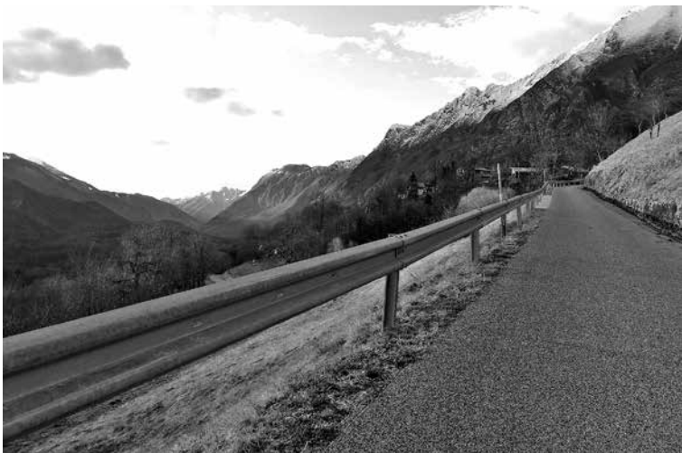
NA NAJNEVARNEJŠE ODSEKE LOKALNE CESTE Drežnica–Drežniške Ravne in dovozne ceste v Jezerca so vgradili varovalno ograjo ter tako izboljšali varnost. Pred Drežniškimi Ravnam pa poteka še urejanje izogibalščja.
