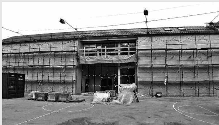
NA SRPENICI GRADIJO GASILSKI DOM Z VEČNAMENSKO DVORANO. Kot je povedal predsednik gradbenega odbora Danijel Krivec , bo objekt z vidika porabe toplotne energije varčen, notranjost bo svetla, vsi prostori pa so zasnovani premišljeno in funkcionalno.
