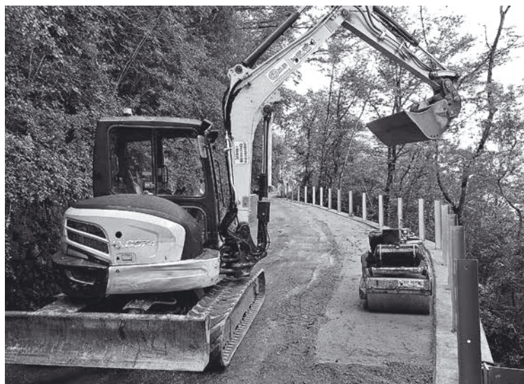
OBČINA TOLMIN IMA ODPRTIH VELIKO GRADBIŠČ NA CESTAH. Sanacija ceste proti Čadrgu bo potekala v več fazah. Foto: Joško Bremec
