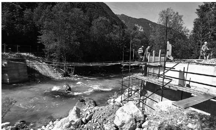
GRADBINCI POSPEŠENO GRADIJO MOST ČREŠNJICA , katerega zaključek je predviden konec avgusta. Občina Bovec bo to začeto naložbo zaključila kljub večjemu proračunskemu izpadu prihodkov zaradi ukrepov za omejitev širjenja koronavirusa inčasnemu zadržanju izvajanja proračuna.
