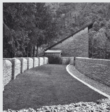
OBNOVLJENA NEMŠKA KOSTNICA V TOLMINU – Sredstva za obnovo so zagotovili v okviru projekta WALKofPEACE. Foto: arhiv izvajalca del
