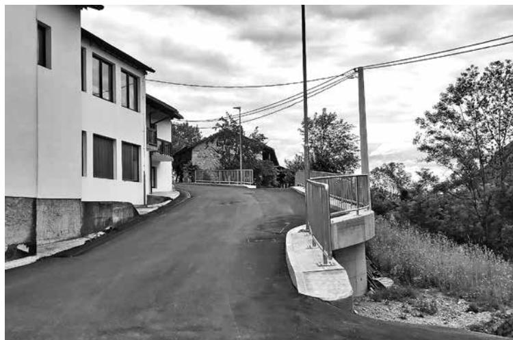
V BORJANI JE NA NOVO UREJENO KRIŽIŠČE državne ceste Staro selo-Breginj in ceste Borjana-Podbela, cesta skozi naselje pa je razširjena.
