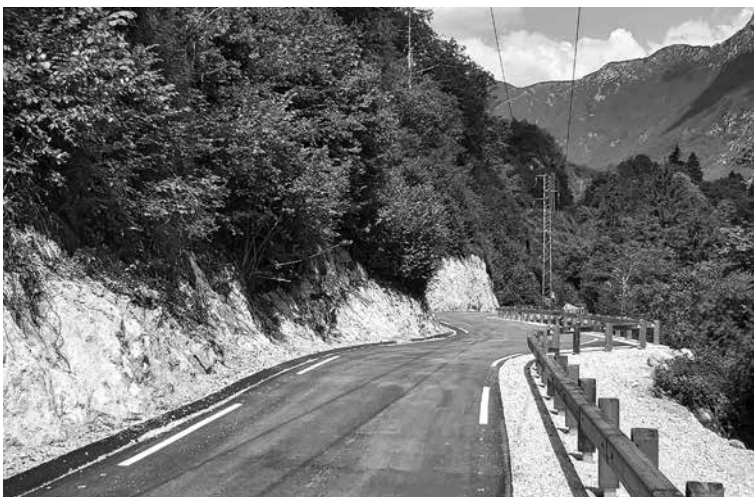
STARA MAKADAMSKA CESTA je urejena in preplaščena z asfaltom. Ko bodo stekla gradbena dela na glavni cesti Kobarid–Bovec, bo služila kot razbremenila cesta za osebna vozila.
