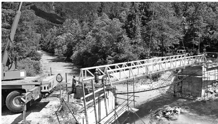
MOST ČREŠNJICA JE DOLG 26 METROV, TEHTA PA KAR 17 TON, zato natovarjanje, prevoz in postavitve čez reko Sočo še zdaleč ni bila preprosta operacija.
