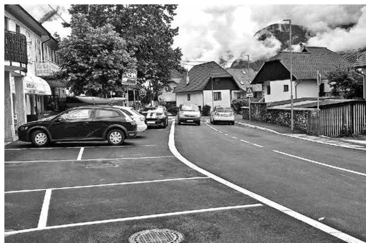
DELA NA BOVŠKI VZHODNI VPADNICI so se zaključila še pred poletno turistično sezono.
