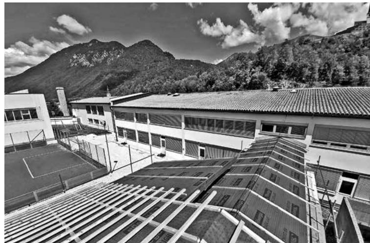
NA STREHI KOBARIŠKE OŠ POTEKA MENJAVA STREŠNE KRITINE , zamenjali pa bodo tudi pod, letve, obrobe in žlebove. Foto: Jernej Bric
