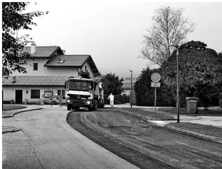
NA STRESOVI ULICI UREJAJO VODOVOD IN KANALIZACIJO. Uredili bodo tudi robnike in preplastili cestišča. Dela bodo predvidoma zaključena konec novembra.
