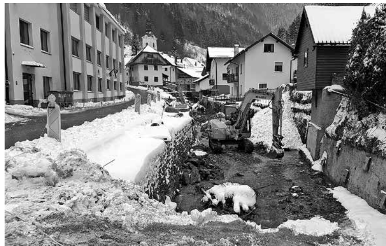
DELAVCI ZAKLJUČUJEJO GRADBENO NAJBOLJ ZAHTEVEN DEL NALOŽBE V PODBRDU, ki je bil nujen za razširitev ceste nad reko Bačo. Po poglobitvi rečne struge in utrditvi obeh bregov so postavili podporne zidove in namestili nosilce, na katerih bo temeljil dodatni pas cestišča.
