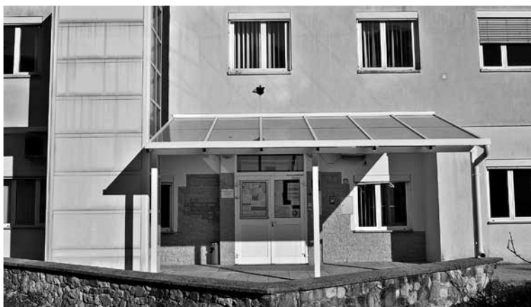
OBČINA BOVEC JE POSKRBELO , da bodo uporabniki bovške zdravstvene postaje na vstop v stavbo lahko počakali pod nadstreškom in bodo tako zaščiteni pred padavinami.
