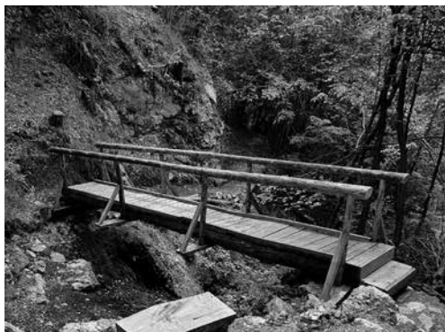
POSTAVITEV BRVI na pohodniški poti Juliana Trail v Baški grapi je le košček v mozaiku vseh do sedaj opravljenih del.
