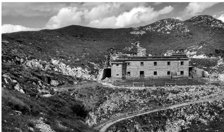
TIK POD SLATNIKOM (1.609 m n. m.) so za obmejno stražo zgradili vojašnico, ki še vedno kljubuje zobu časa. Foto: Damjana Fortunat Černilogar
