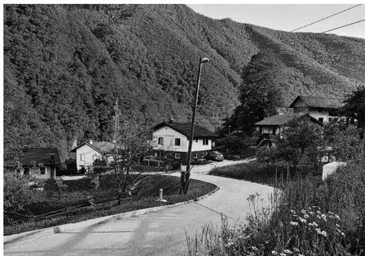
SIDRANI PILOTNI STENI POD STANOVANJSKIMI HIŠAMI v dolžini 75 in 50 metrov, ki bosta izvedeni v II. fazi sanacije, bosta bistveno omilili nadaljnje premike in poškodbe objektov pod cesto v naselju Grahovo ob Bači. Foto: Eva Levpušček
