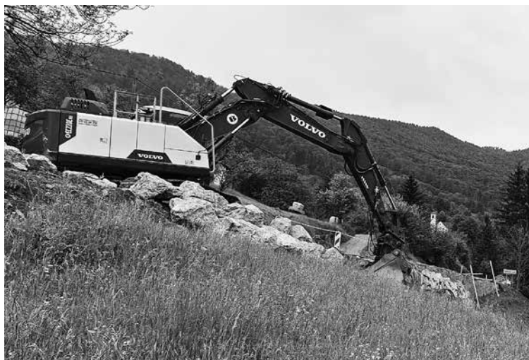
OBČINA TOLMIN BO V KRATKEM PRISTOPILA TUDI K SANACIJI dveh odsekov ceste med Drobočnikom in Kanalskim Lomom. Foto: Sanja Sivec Levpušček
