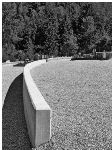
NA POKOPALIŠČU V DREŽNICI se bo nadaljevala ureditev odvodnjavanja in podpornih zidov z izdelavo terasastega polja. Foto: Nataša Hvala Ivančič
