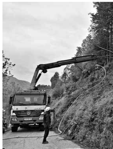
UREJANJE ZAŠČITE VOZIŠČA PRED PADAJOČIM KAMENJEM na enem od odsekov lokalne ceste med naseljem Vrsno in Krn. Foto: arhiv Občine Kobarid
