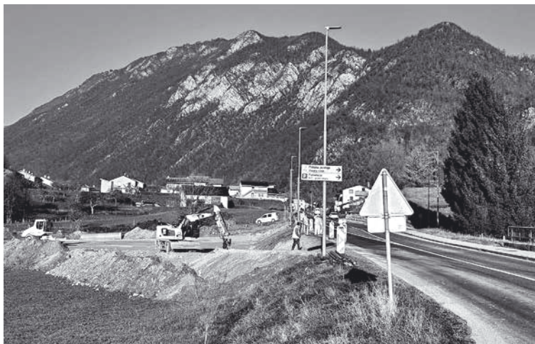
V KOBARIDU SO STEKLA DELA ZA IZGRADNJO KROŽIŠČA , ki bodo zaključena predvidoma do oktobra prihodnje leto.
