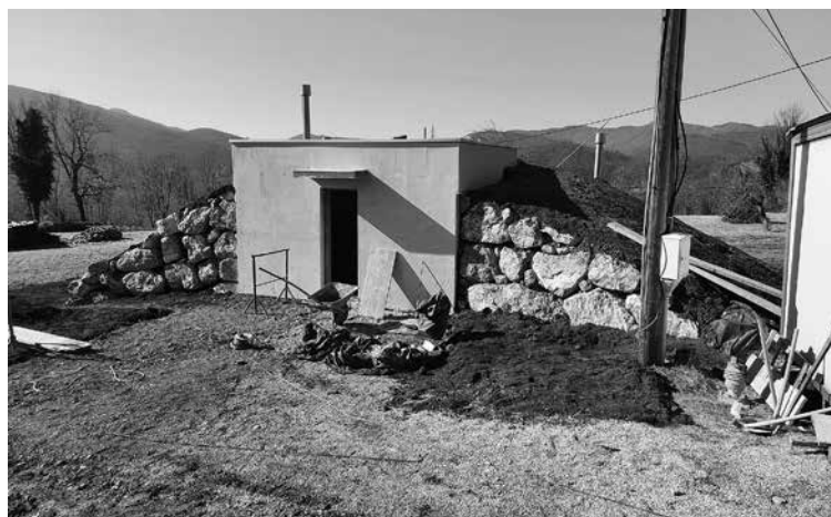
GRADNJA VODOHRANA v naselju Stanovišče. Foto: Jernej Bric
